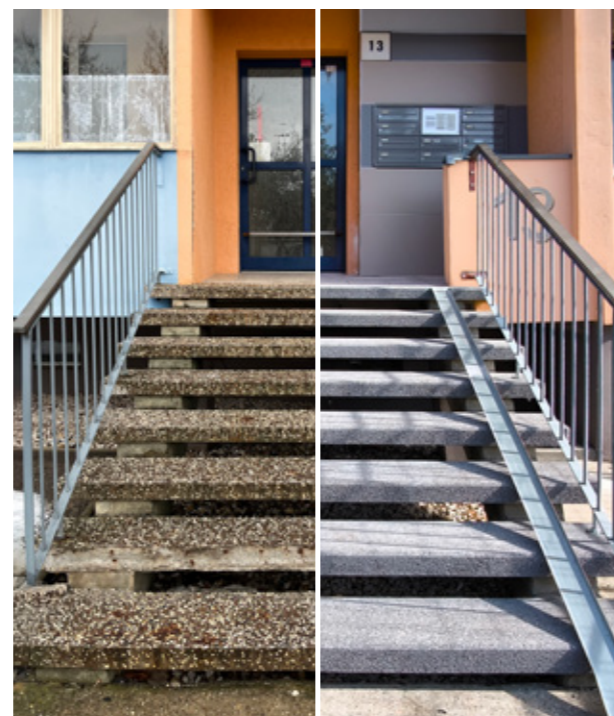
Lerchenbergstraße 13 vor und nach der Außentreppeansanierung
