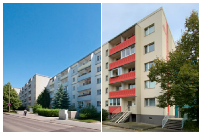
Lerchenbergstraße 48-51 vor und nach der Fassadensanierung
